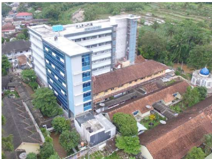
Gambar 3.18 Gedung 7 lantai RSUD Kab. Temanggung
