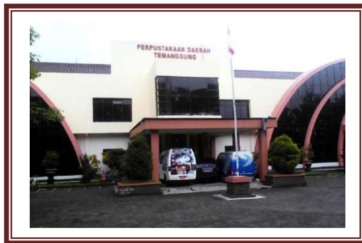
Gambar 3.16 Gedung Arpusdok Kab. Temanggung
