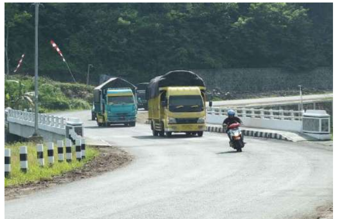
Gambar 3.22 Jembatan Seroyo setelah dibangun
