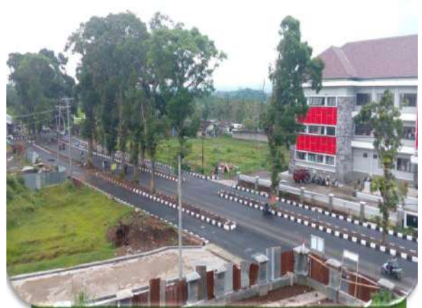
Gambar. 3. 20 Pembangunan Jalan Pahlawan
