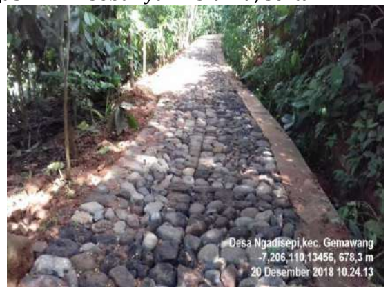
Gambar 3.6. Pembangunan infrastruktur Jalan Usaha tani
