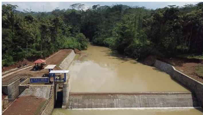
Gambar 3.24 Bendung Tingal di Kecamatan Kaloran
