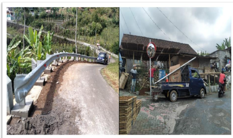
Gambar 3.30 Pemasangan Pagar Pengaman Jalan ( Guardrail ) dan Cermin Tikungan di Desa Katekan Kecamatan Ngadirejo
