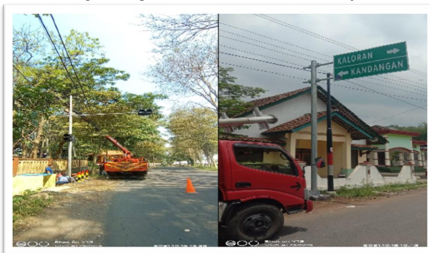
Gambar 3.31 Pemasangan Lampu Lalu Lintas dan Rambu Penunjuk Jalan
