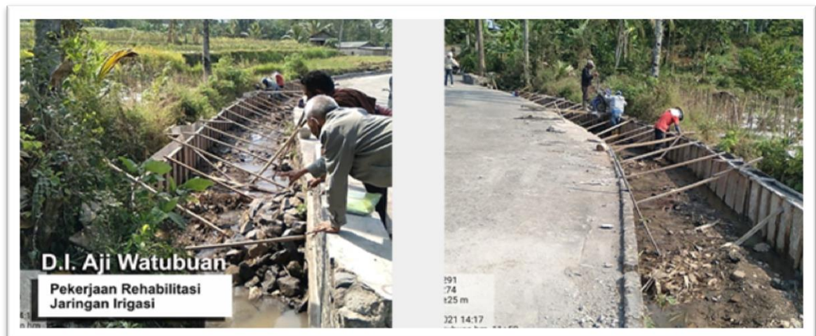
Gambar 3.27 Pekerjaan Rehabilitasi Jaringan Irigasi D.I. Aji Watubuan Desa Wonokerso Kecamatan Tembarak
