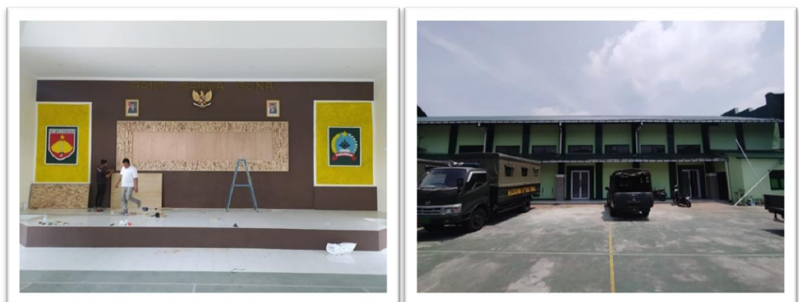
Gambar 3.28 Rehab Gedung Sarwo Guno dan Sarpras Jalan Rumah Dinas Kodim
