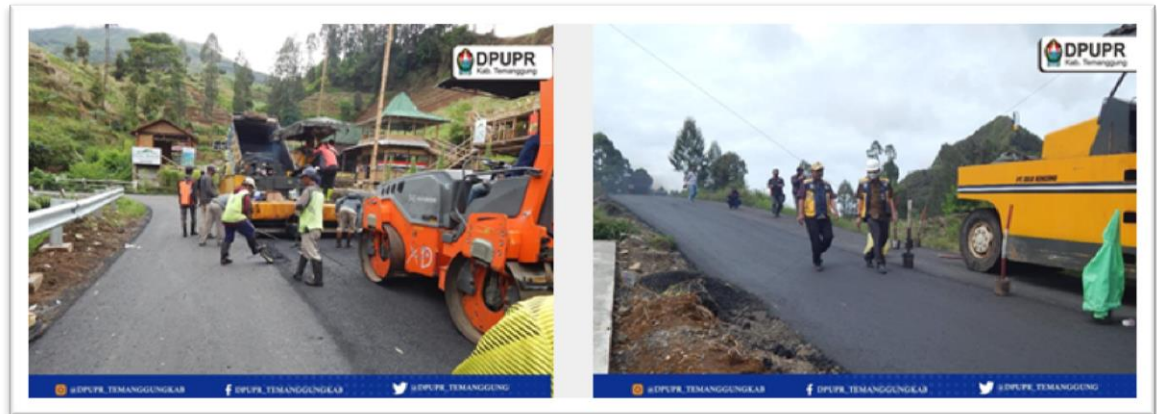
Gambar 3.26 Pekerjaan Pelebaran Jalan Jumprit – Sibajag
