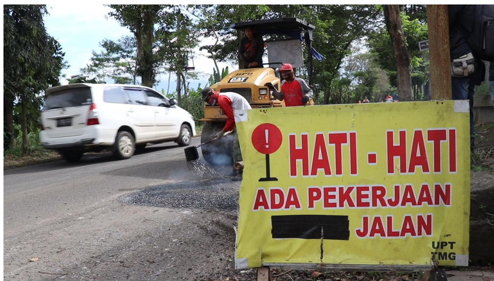
Gambar 2.38 Perbaikan Jalan Lingkar Temanggung Tahun 2022
